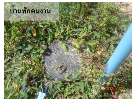
ภาพที่ 2.2-7 ถังบำบัดน้ำเสียสำเร็จรูปภายในพื้นที่ก่อสร้างและบ้านพักคนงาน
