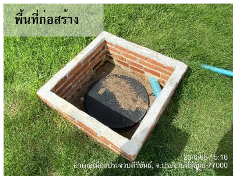
ภาพที่ 2.2-7 ถังบำบัดน้ำเสียสำเร็จรูปภายในพื้นที่ก่อสร้างและบ้านพักคนงาน
